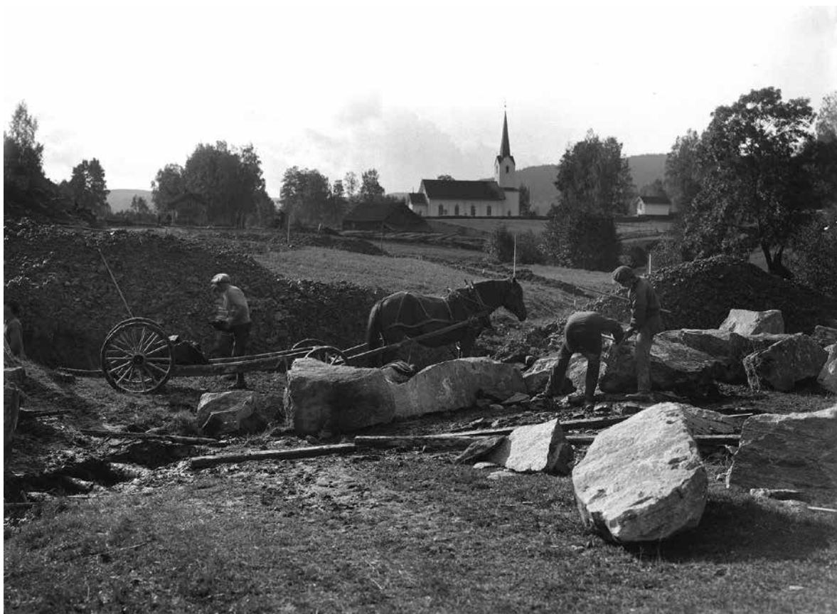
Vändskivan för bl.a.lokomotivet byggs i Skillingmark. Lokstallet byggdes också ungefär här.
